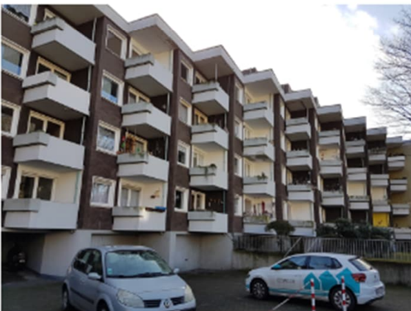
König-Friedrich-Wilhelm-Str. 44 vor der Sanierung
